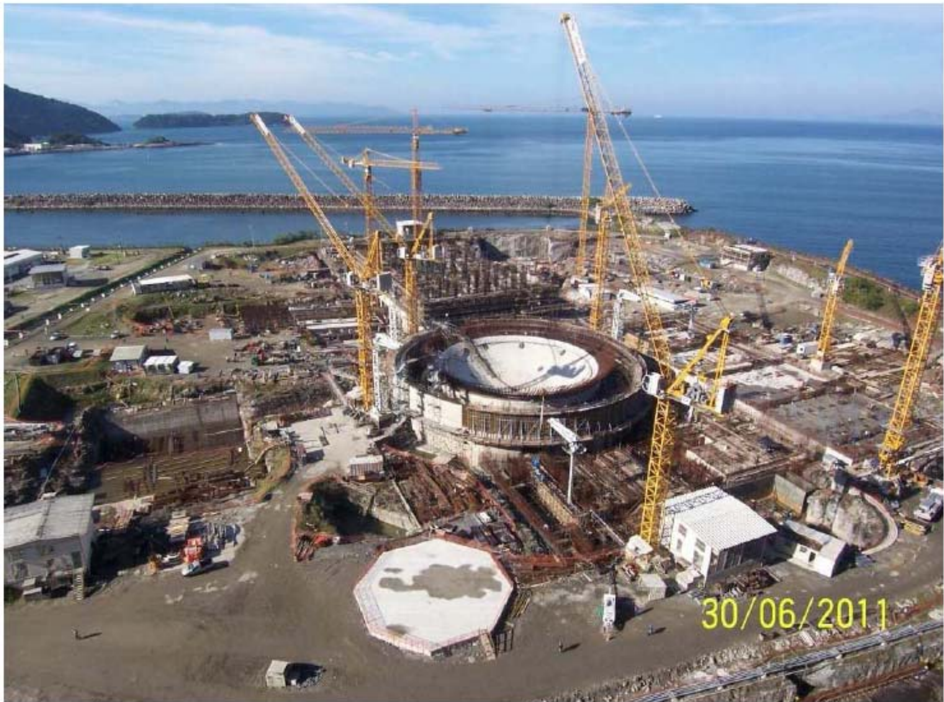
Sítio de Angra 3 – status de construção do Edifício do Reator (foto Eletronuclear)
