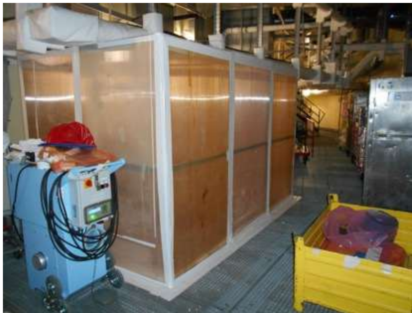
Figure 2. Schéma de principe du confinement stato-dynamique
